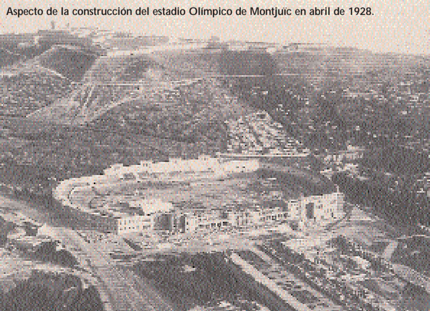
Aspecto de la construcción del estadio Olímpico de Montjuïc en abril de 1928.
