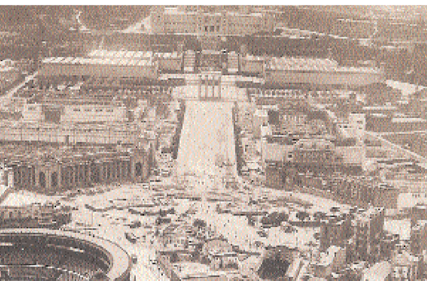
Aspecto de la construcción del eje Plaza de España/Palacio Nacional en abril de 1928.
